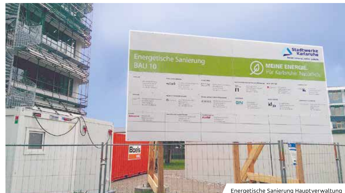
Energetische Sanierung Hauptverwaltung
