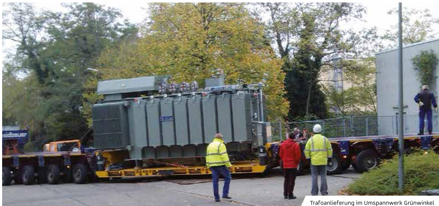
Trafoanlieferung im Umspannwerk Grünwinkel
