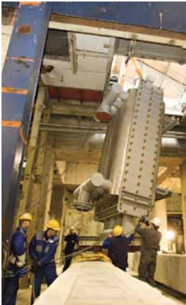
Installation eines neuen Plattenwärme-tauschers im HKW West zur Einbindung der Raffinerieabwärme
