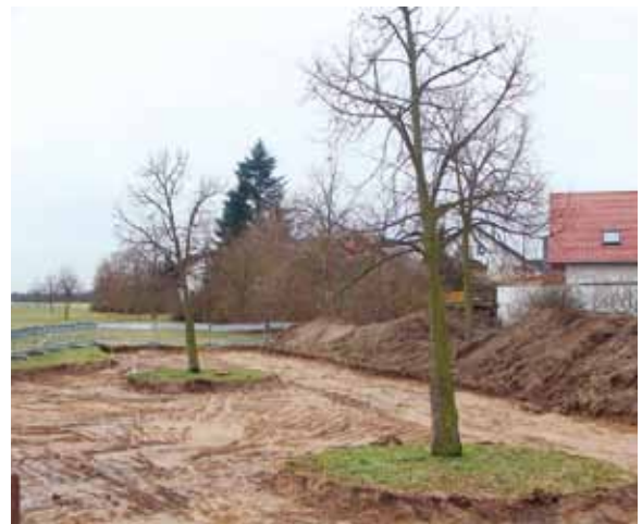
Freihaltung des Wurzelbereichs beim Bau der Leitung zur Fernwärmeversorgung Nord
