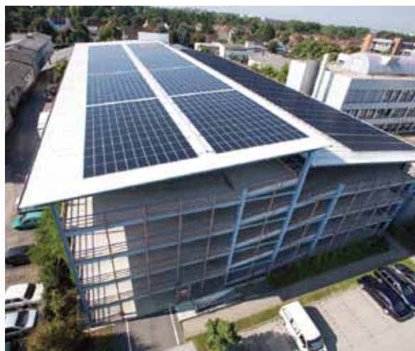
Solaranlage auf dem Dach des Parkhauses der Stadtwerke Karlsruhe
