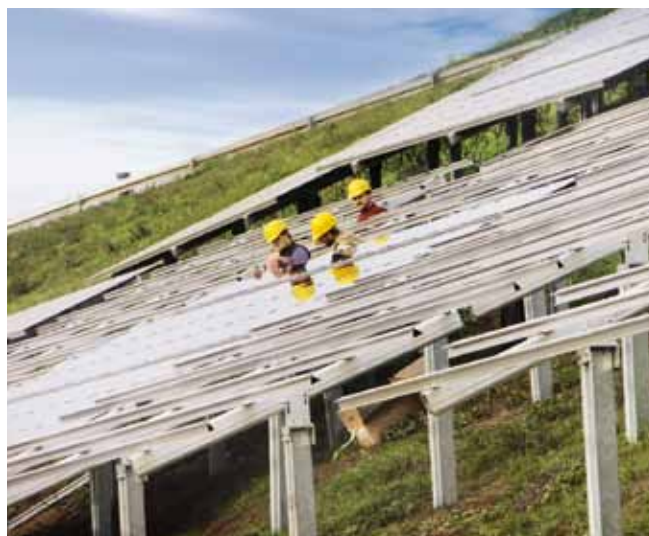
Montage der Photovoltaikanlage auf dem Energieberg
