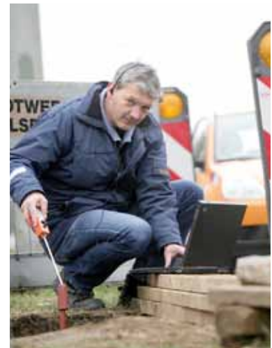
Messung bei Gaslecksuche
