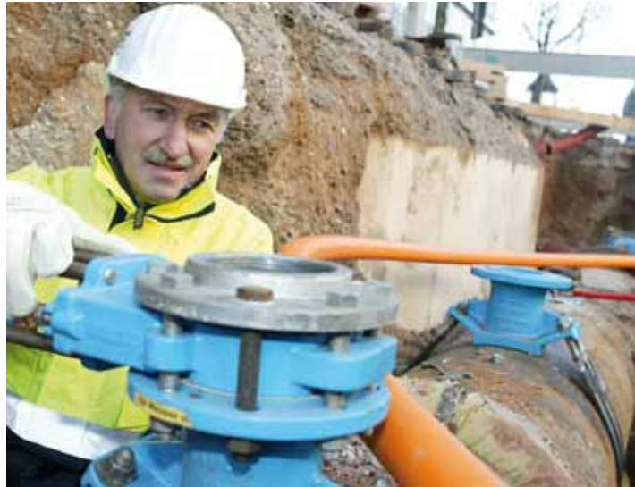
Bauarbeiten an einer Trinkwasserrohrleitung
