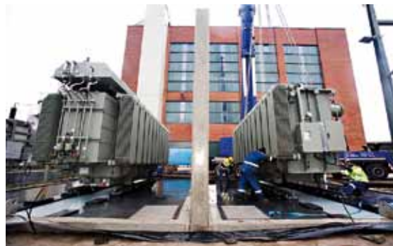
Anlieferung der neuen energiesparenden 110/20kV-Umspanner
