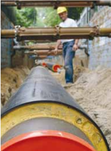
Blick in einen Leitungsgraben
