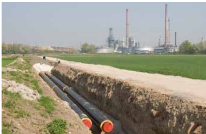
Bau der Transportleitung zwischen der Raffinerie MiRO und dem Heizkraftwerk West
