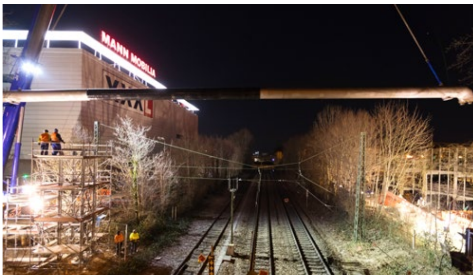
Eine Rohrbrücke zur Überquerung der Bahngleise wurde Ende Februar als letztes noch fehlendes Teilstück der neuen Fernwärmeleitung nach Durlach montiert.
