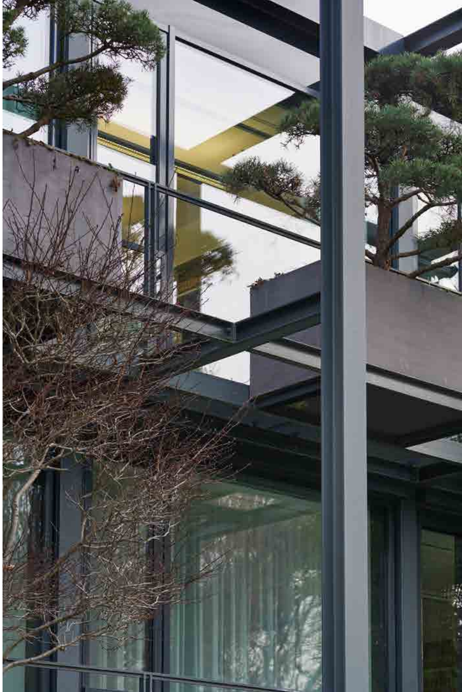
Bundesverfassungsgericht, Erweiterungsbau, Schlossbezirk 3
